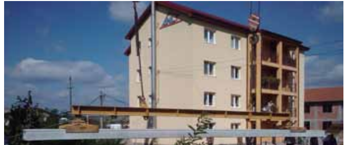
BLOC ANL DE PE CALEA LUGOJULUI - după ce s-a amenajat o parcare cu dale și s-au amplasat două pergole a fost demarată construcția unui pod de acces pietonal
