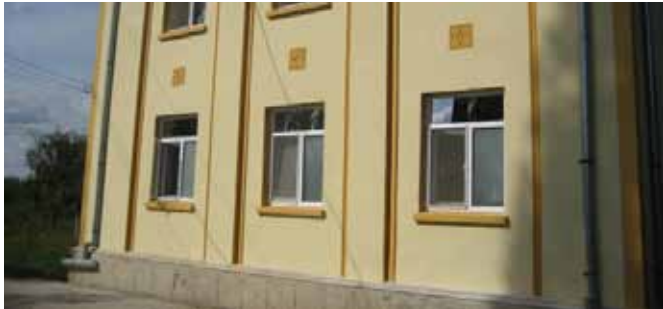
LA SPITALUL ORĂȘENESC FĂGET - s-a renovat fațada secției de chirurgie
